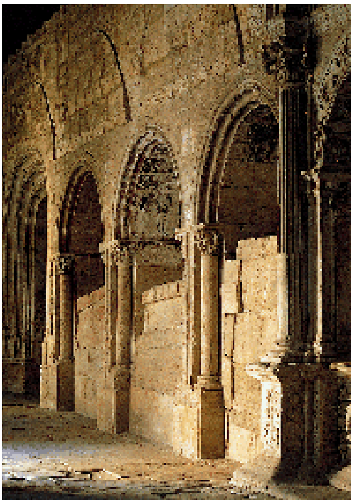
Galería oriental del claustro
