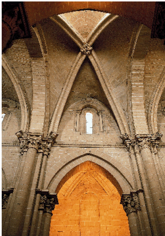
Bóvedas de la nave central
