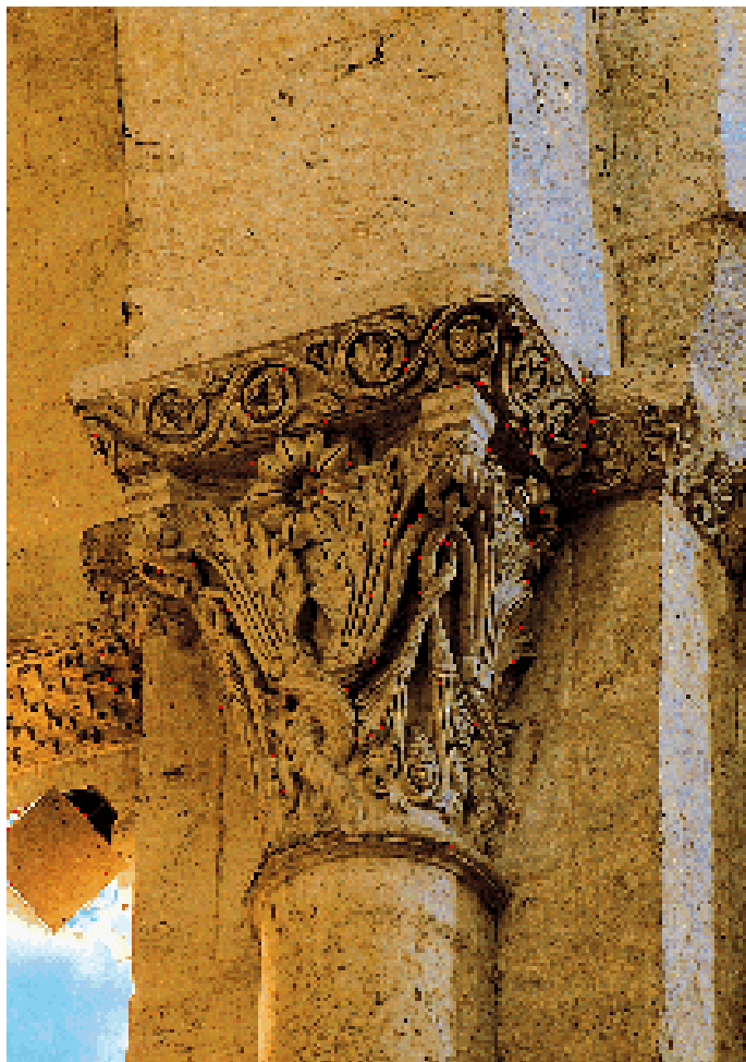
Capitel vegetal de la nave
