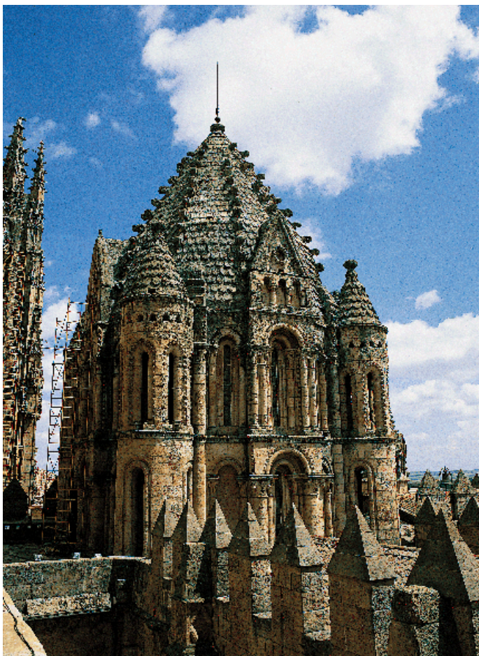
La Torre del Gallo
