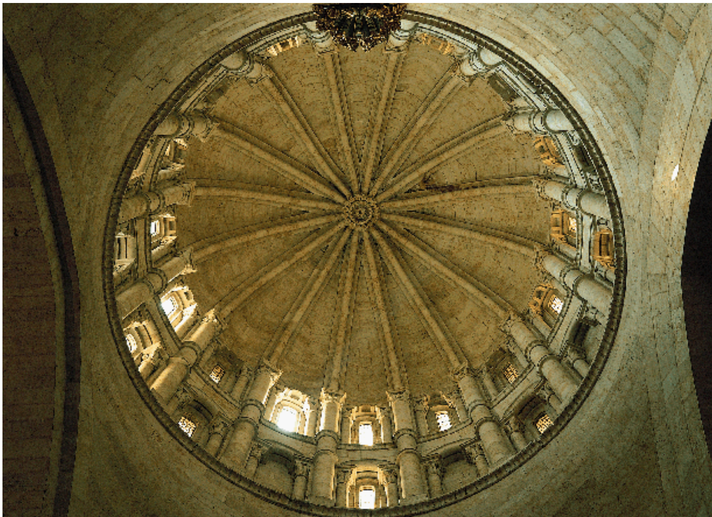
Interior del cimborrio
