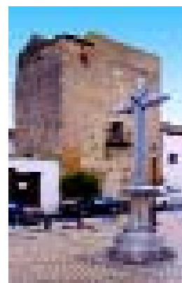
Torreón árabe en Las Gabias
