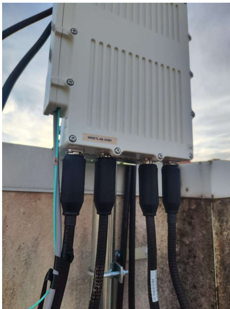
Figura 5.5: Conexión física con una de las antenas de la red exterior.
