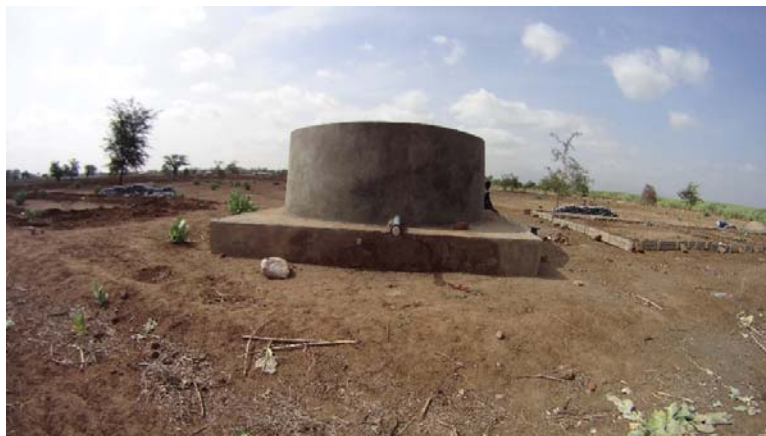
Fig 2.- Depósito de regulación construido con los “ecoladrillos”
