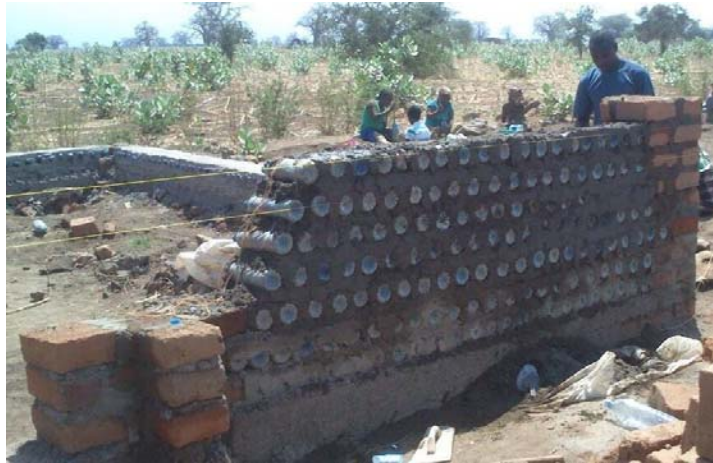
Fig 1.- Ejemplo de muro con los “ecoladrillos”
